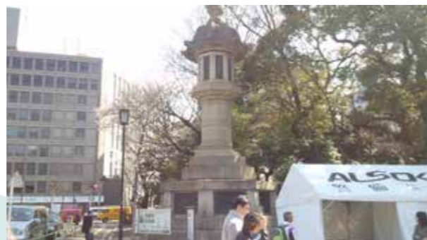
靖国神社 大燈籠 耐震化工事
